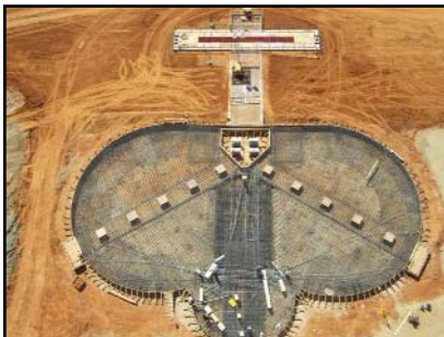
Above: Silo foundation slab ready to pour
